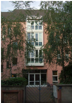
Pflegeheim Bockenheim mitten im Stadtteil Bockenheim gelegen
